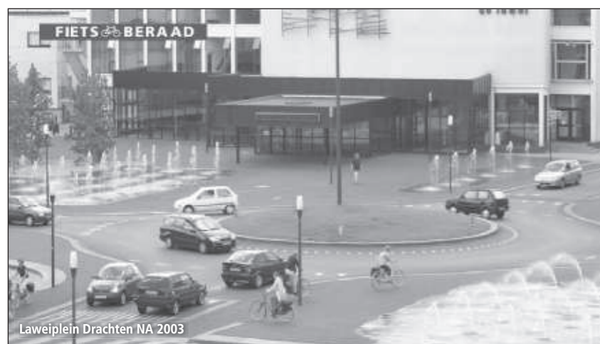
Het Laweplein in Drachten vóór (boven) en na de herinrichting in 2003 (onder). Door minder te regelen letten de verkeersdeelnemers meer op elkaar en verloopt de verkeersstroom beter en veiliger. [Bron: CROW-Fietsberaad]
